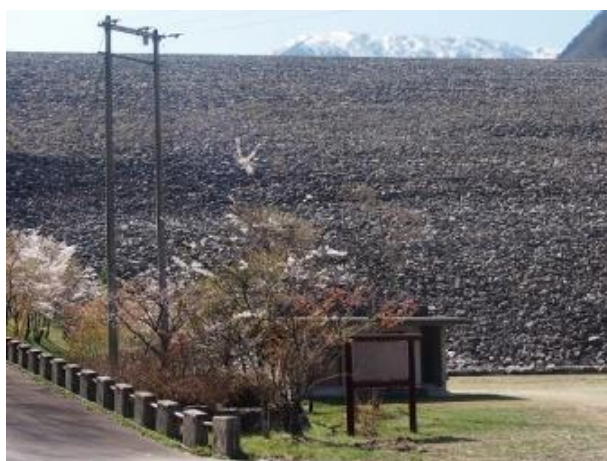
▲ 大町ダムの上流には東京電力の七倉ダムが造られている。5月4日に撮影。
