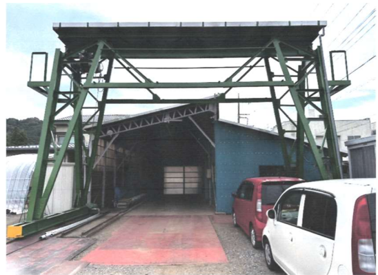
▲ 門型クレーン
