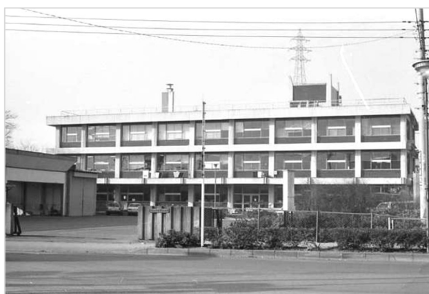
▲ 写真 3 : 3 階建て鉄筋コンクリート造りの沼影庁舎
